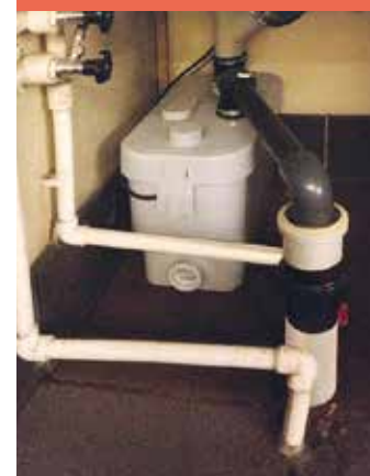
Насос SANISPEED® установлен под раковиной
