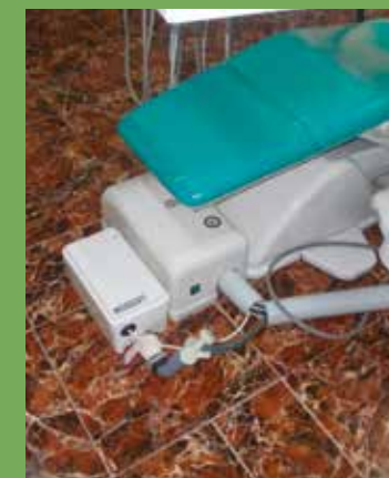
Насос SANIDOUCHE® установлен для отведения стоков от раковин
