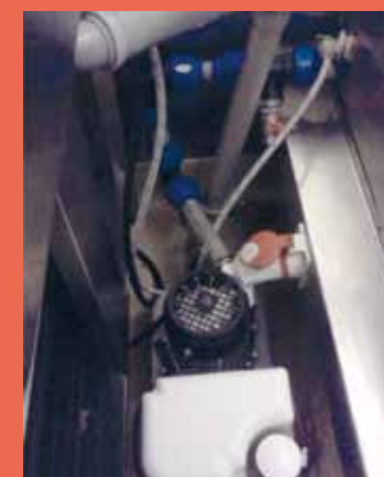
Установленная насосная станция SANICOM® 1
