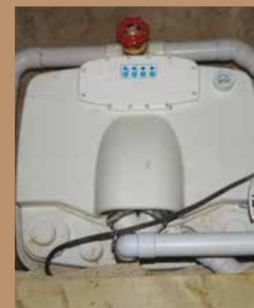
Насосная станция SANICUBIC® 2 Pro установлена в подвале
